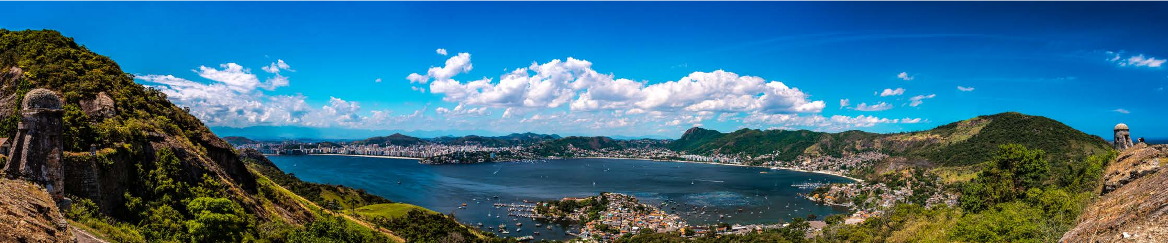
Figura 1 - Vista do Forte do Pico (Área de Proteção Ambiental - APA - do Morro do Morcego, da Fortaleza de Santa Cruz e dos Fortes Pico e Rio Branco) para a Montanha da Viração (Parque Natural Municipal de Niterói - PARNIT - Setor Montanha da Viração).
