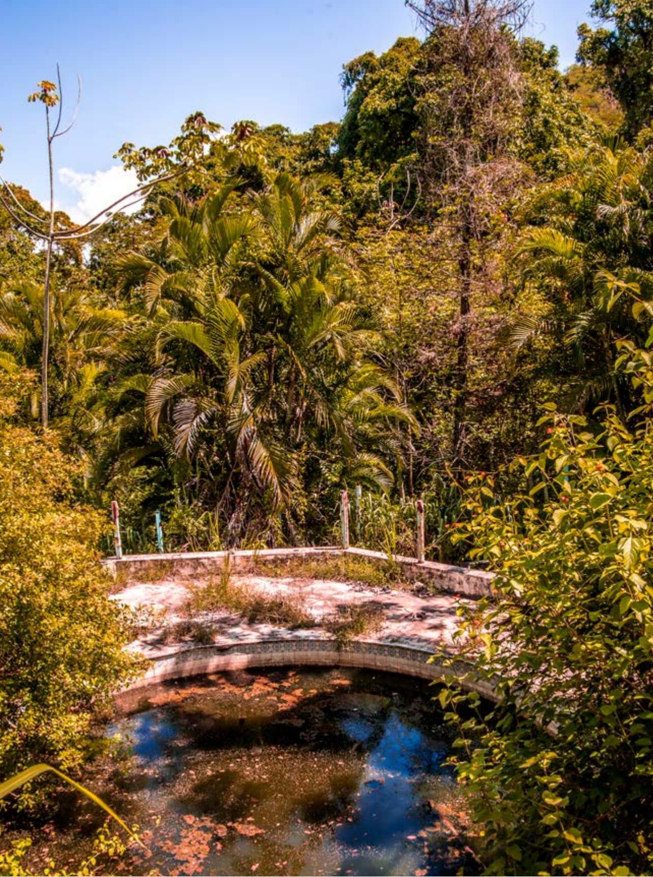
Figura 46 - Primeiro aqueduto de Niterói, localizado na APA da Água Escondida.
