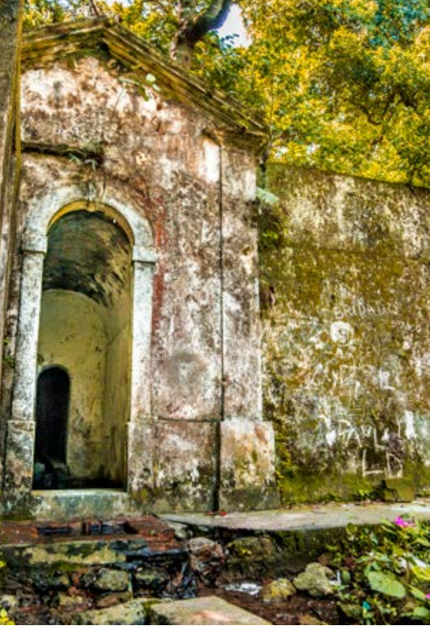
Figura 44 - Primeiro aqueduto de Niterói, localizado na APA da Água Escondida.
